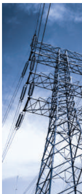
Electrical & Industrial ไฟฟ้า
